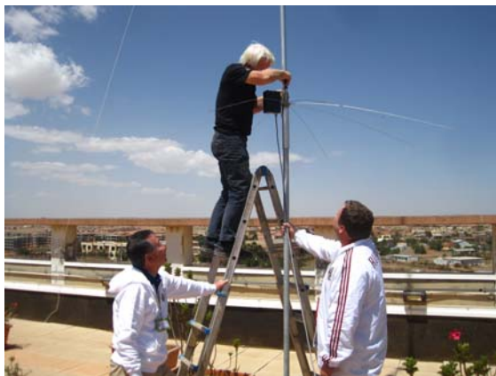
Abb. 2 Franz, DJ9ZB bei der Endmontage der Cushcraft R7 Vertikal
