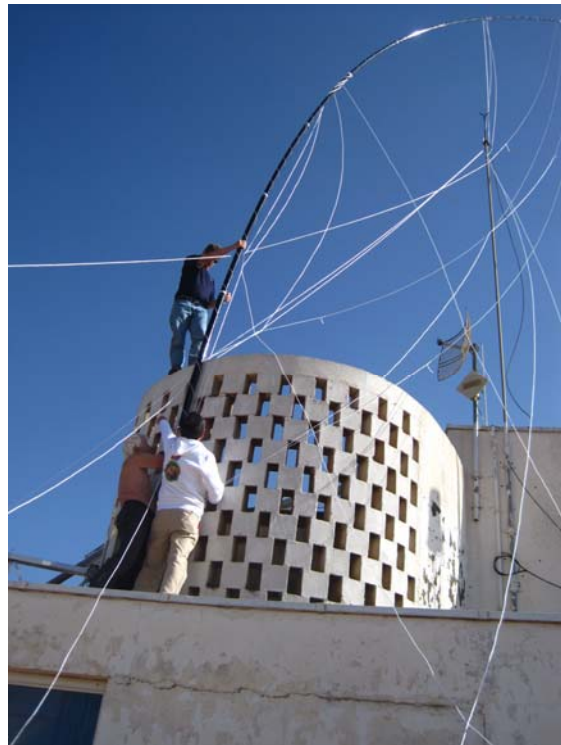
Abb.4 Montage der 160 / 80m Vertikal Antenne
