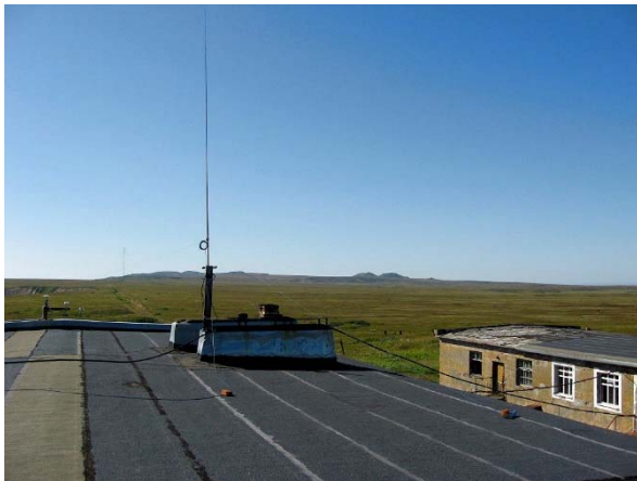
20m - GP auf dem Dach
