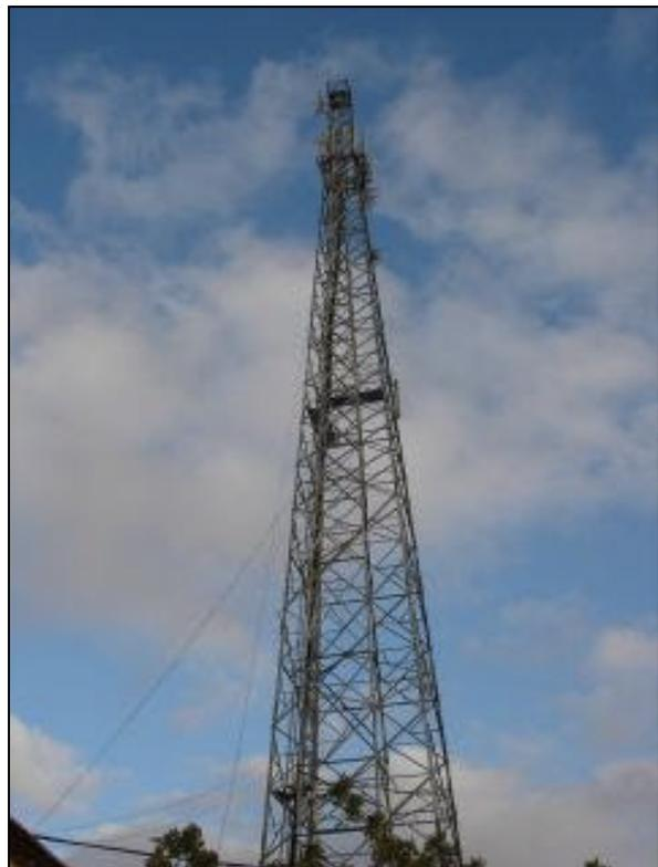
50 m Mast von Radio Daljir mit inverted-V
